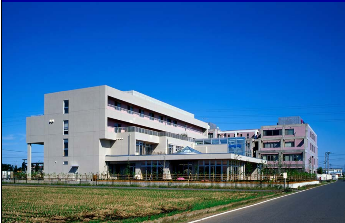
愛和病院ANNEX「赤ちゃんワールド館」(2006)
